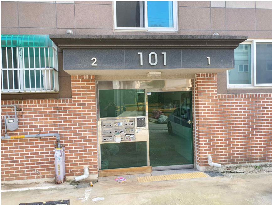
본건 1층 공동현관
