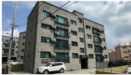
[본건 소재 다세대주택 전경]
