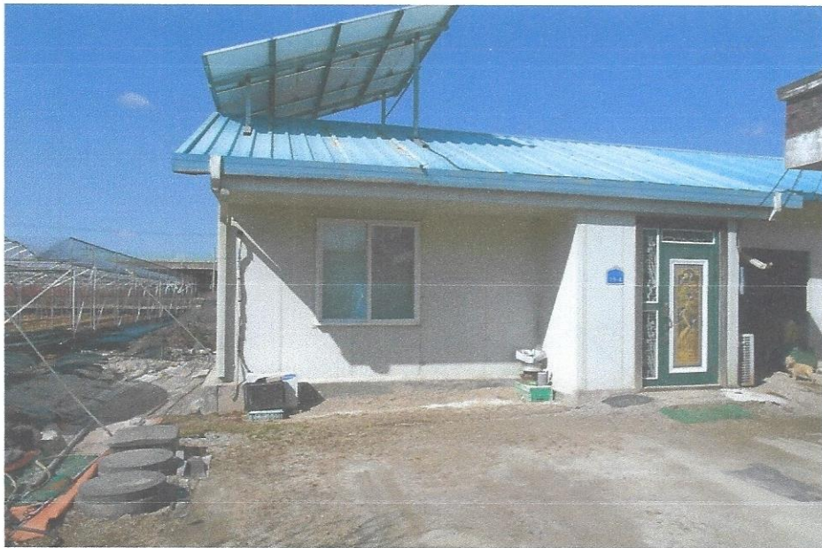
본건 건물(대대적 보수로 경량철골조 판넬지붕 단층으로 보수공사함)
