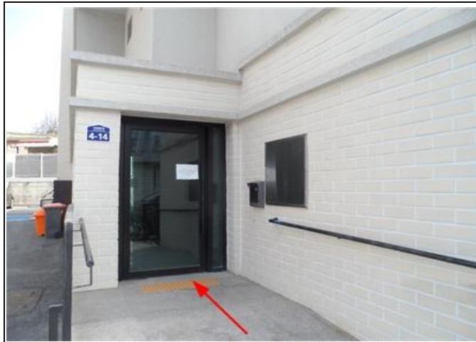
제102동 1, 2층 출입구부분//남측 촬영
