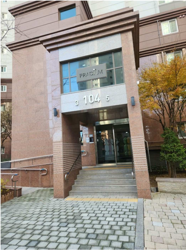
본건 공동 출입구
