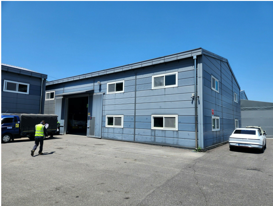
본건 일련번호 4 전경
