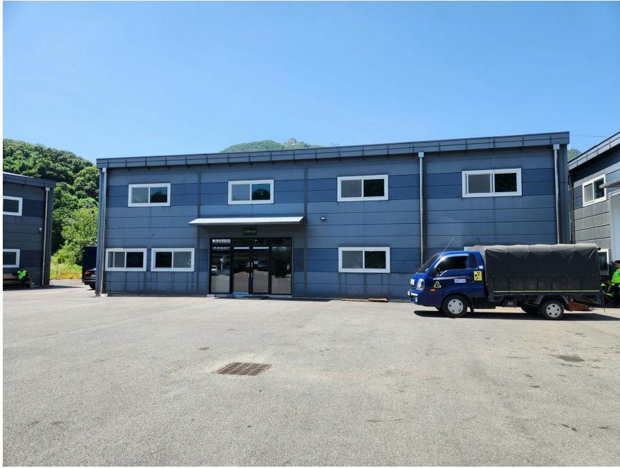
본건 일련번호 3 전경
