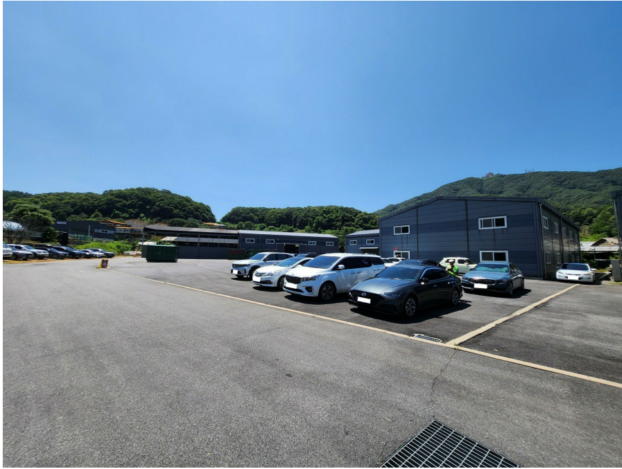
본건 일련번호 1~5 전경
