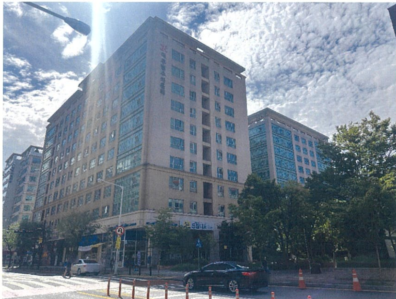
대상물건 전경 (북측 촬영)
