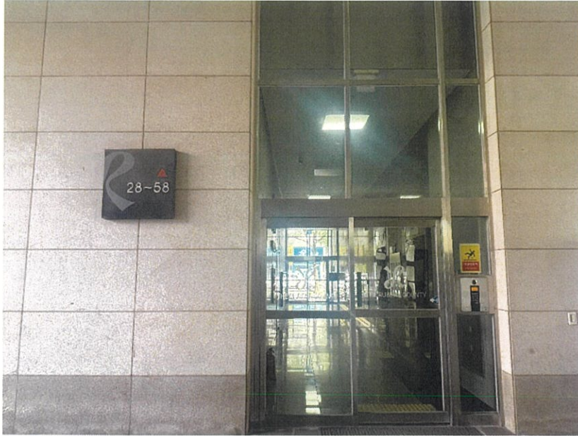
대상물건 전경 (공동 출입구)
