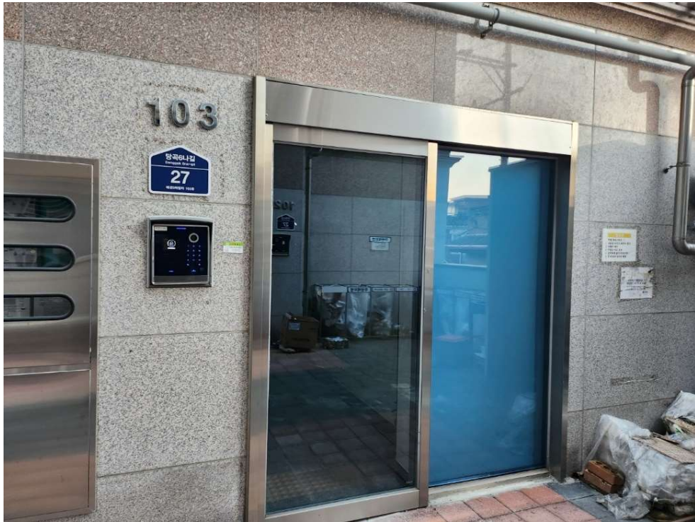
본건(1) 1층 출입문
