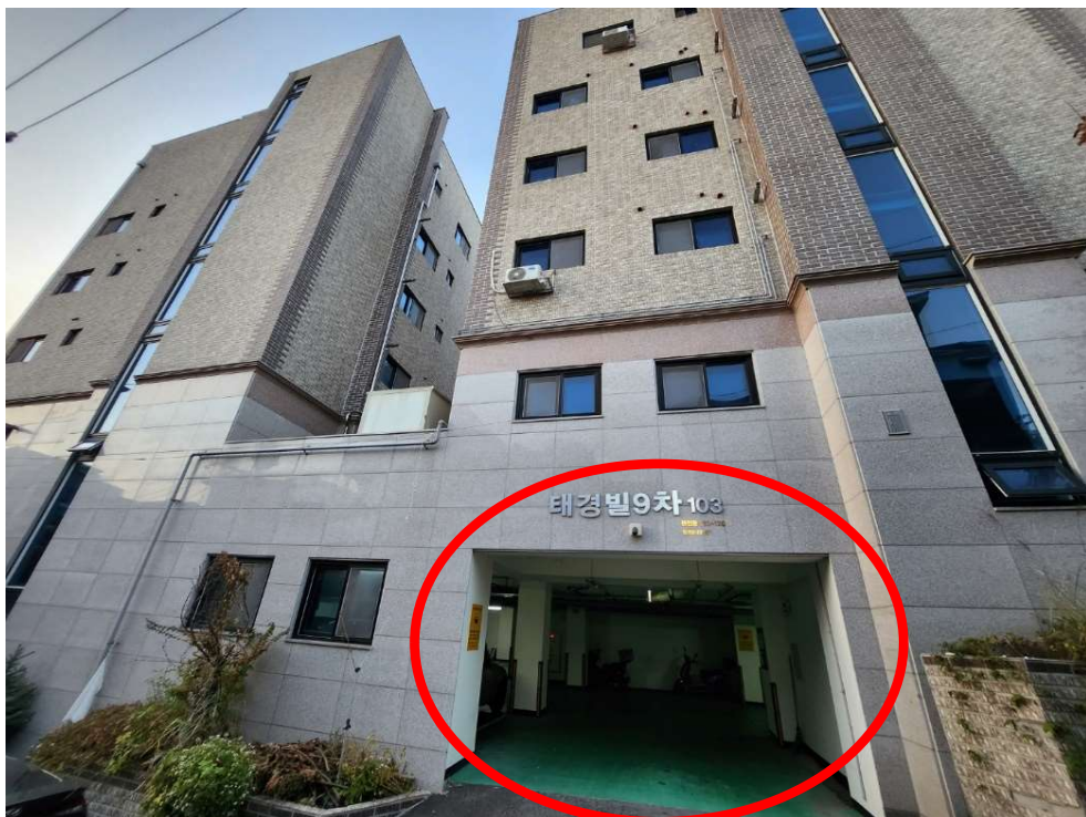
본건(1) 지층 주차장 출입구
