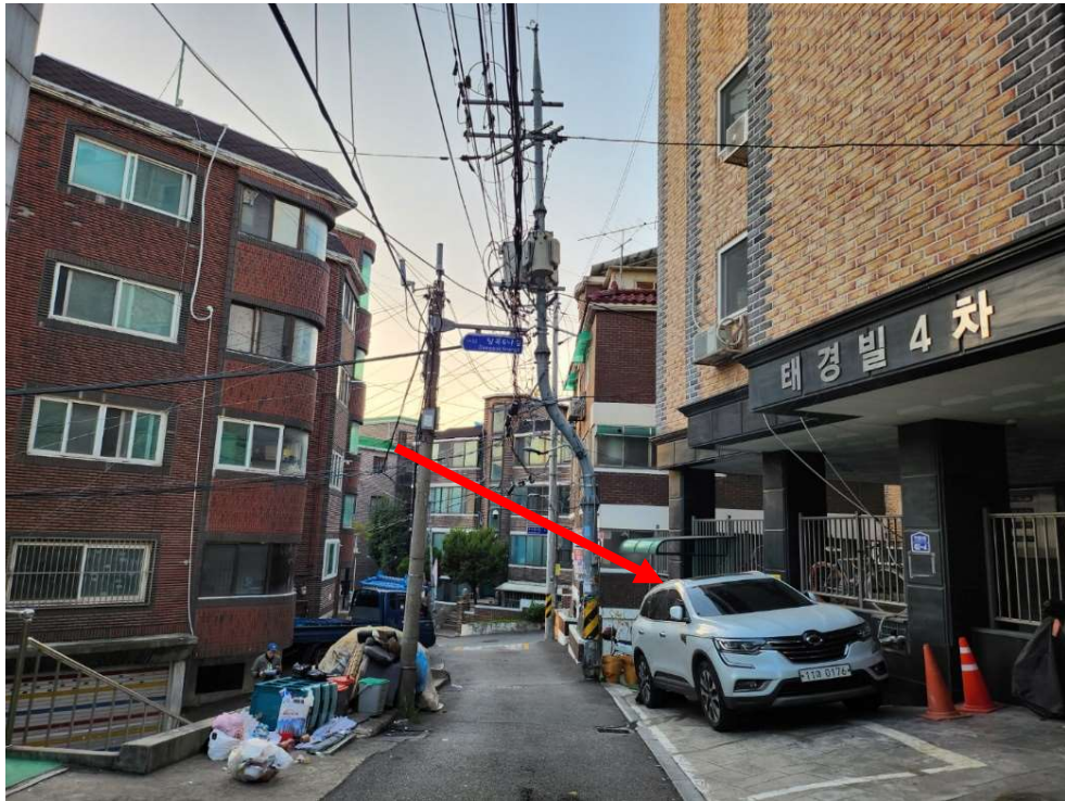
본건(2) 주위전경(남동측 촬영)
