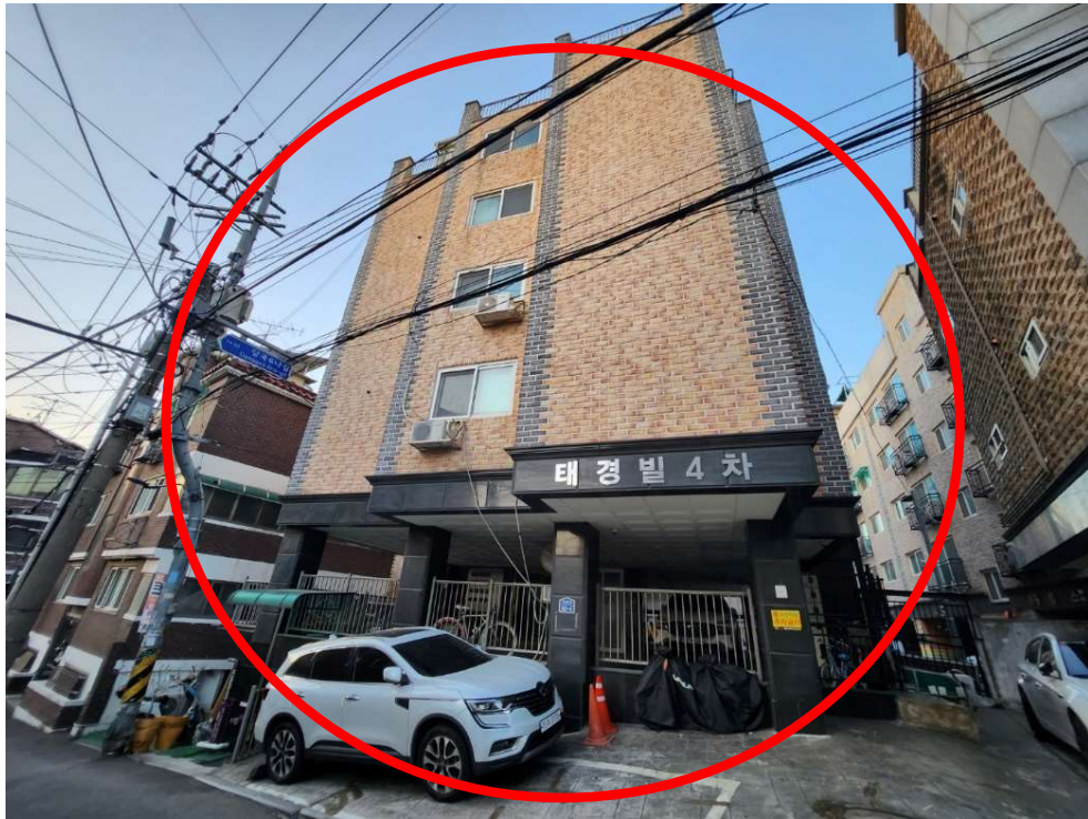
본건(2) 전경 (남측 촬영)
