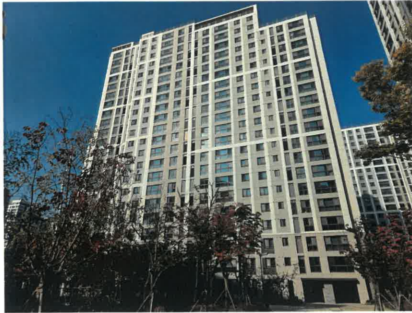
본건 남동측 전경
