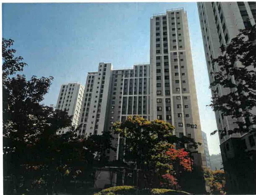
본건 북서측 전경
