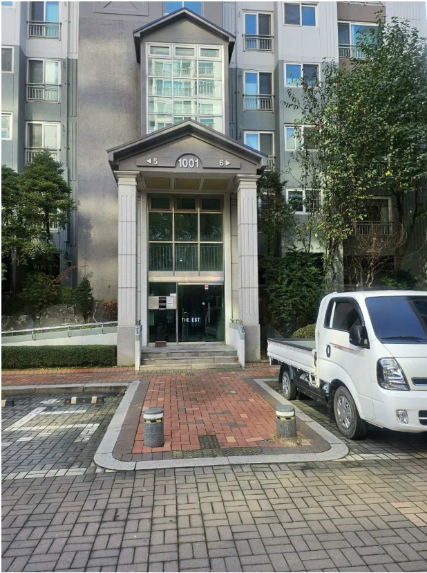
본건 공동 출입구
