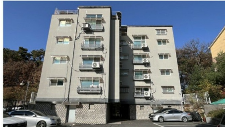
[본건 소재 다세대주택 전경]
