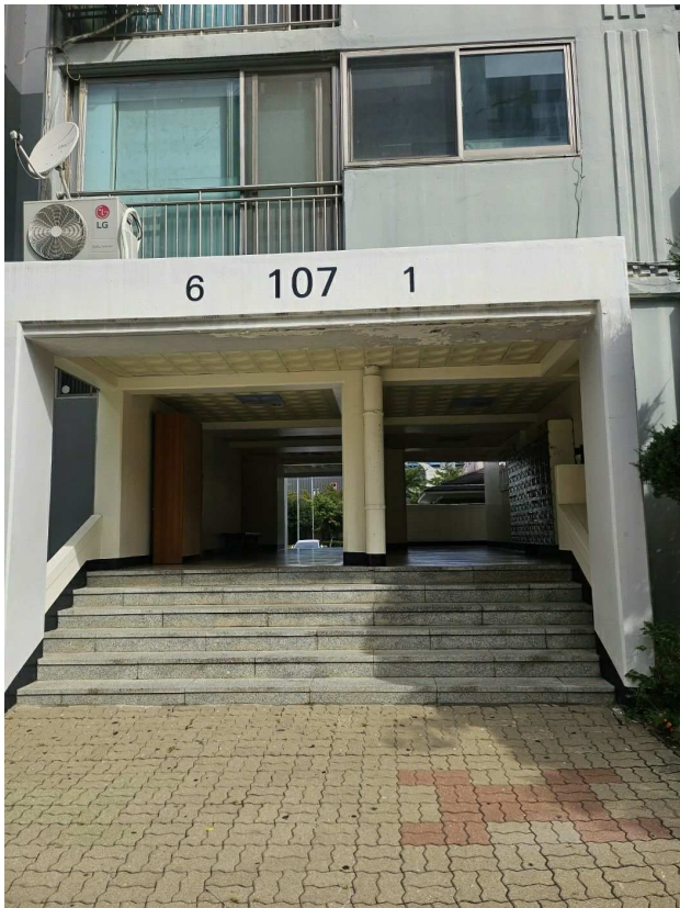
본건 공동 출입구
