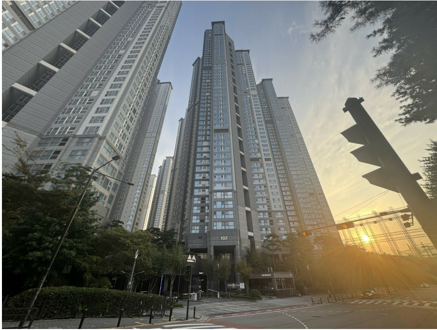
본건 건물 102동 전경
