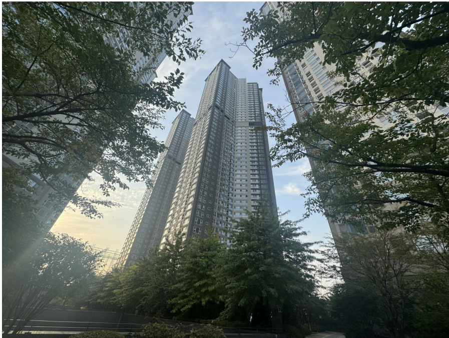
본건 건물 102동 전경
