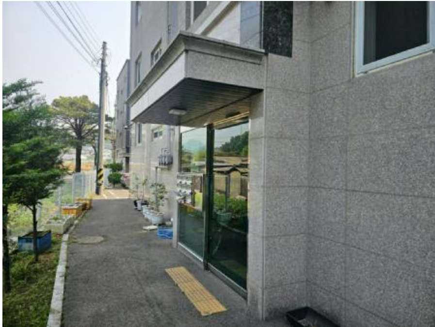
대상물건 건물 1층 출입구
