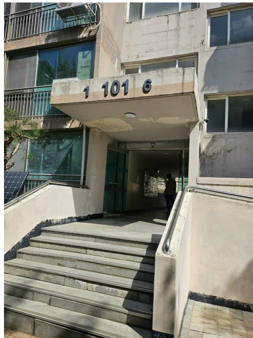
본건 공동 출입구
