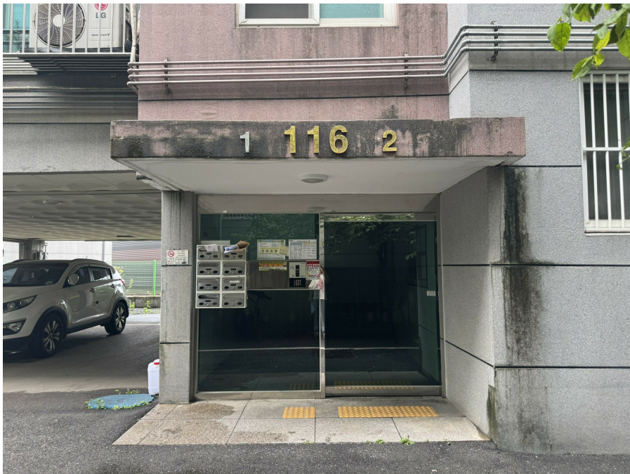
본건 1층 출입문
