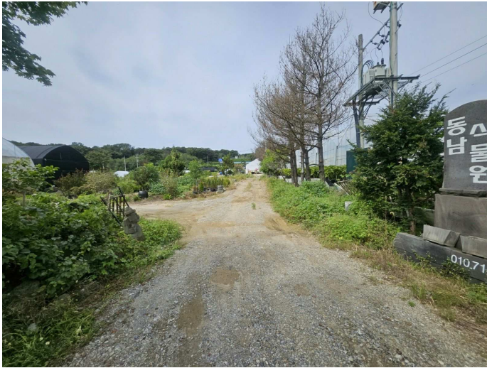
본건(기호2) 전경 (본건 남동측에서 촬영)
