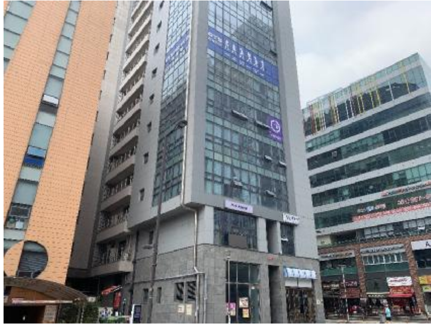
【본건 전경 - 남동측에서 촬영】
