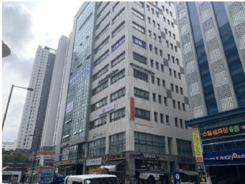
【본건 전경 - 북서측에서 촬영】
