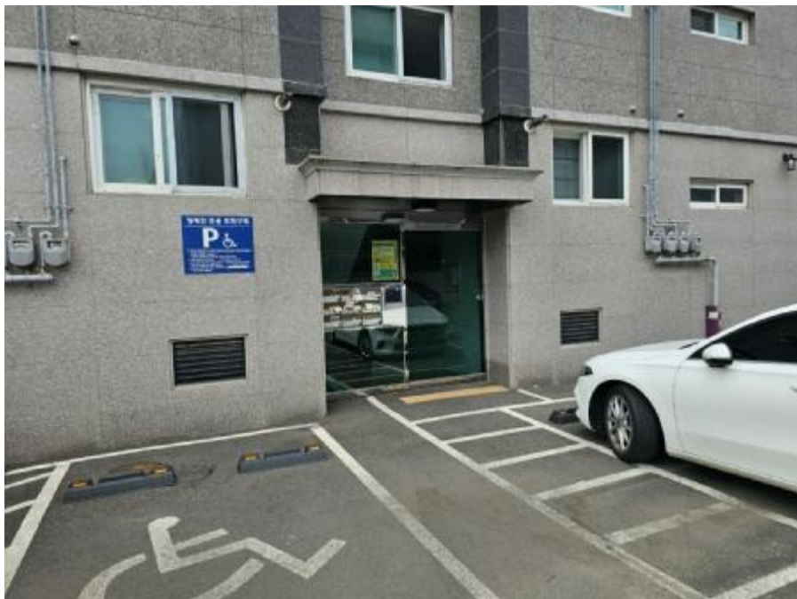
대상물건 건물 1층 입구
