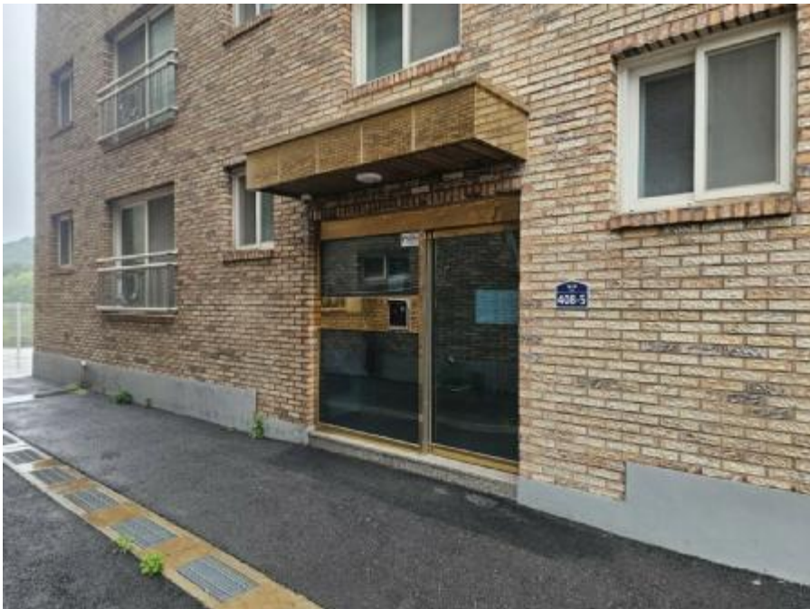
대상물건 건물 1층 출입구
