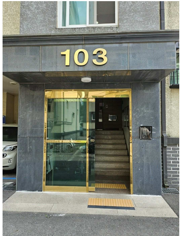
본건 공동 출입구
