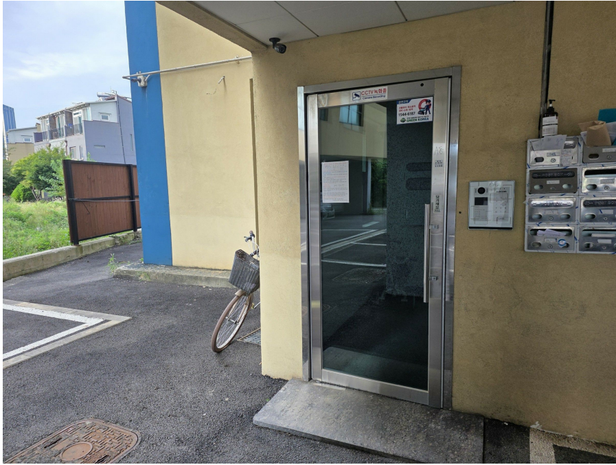
본건 공동 출입구
