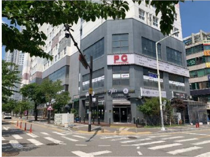
【본건 전경 - 남서측에서 촬영】
