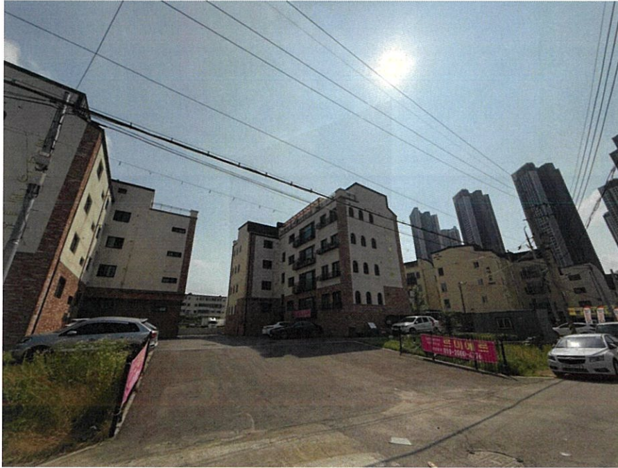
본건 단지내 전경
