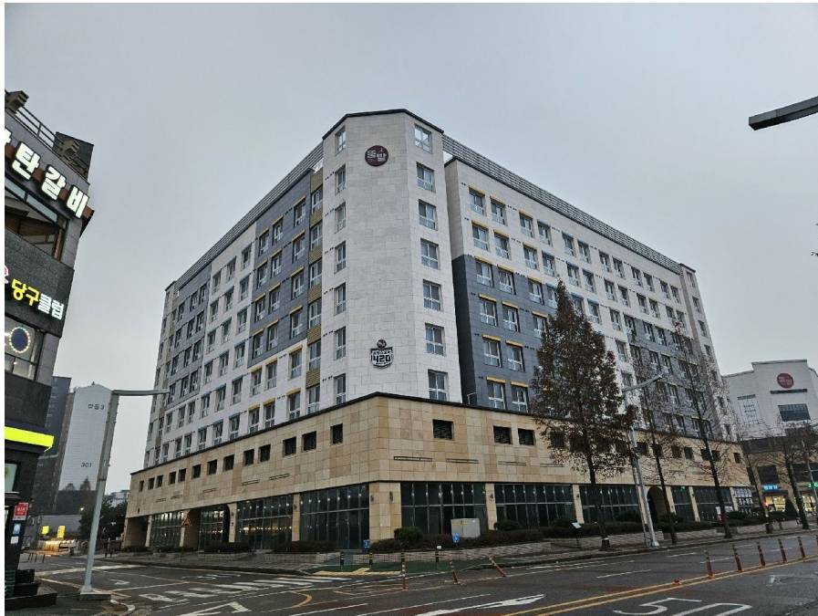
본건 전경 (북동측에서 촬영)
