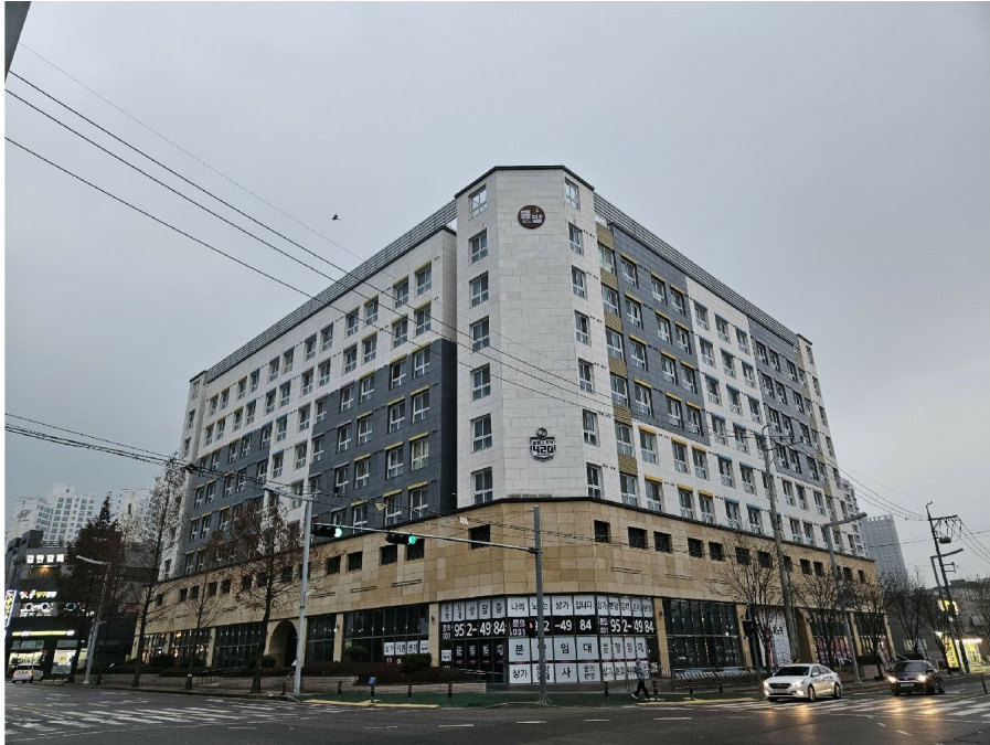
본건 전경 (북서측에서 촬영)
