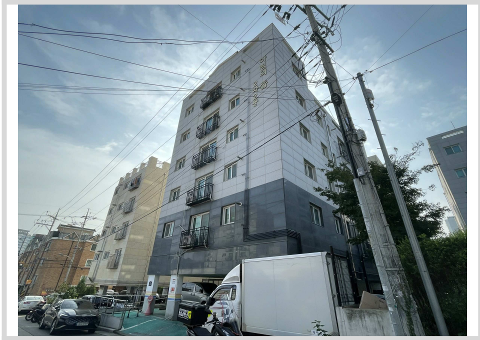
본건 건물 전경-3
