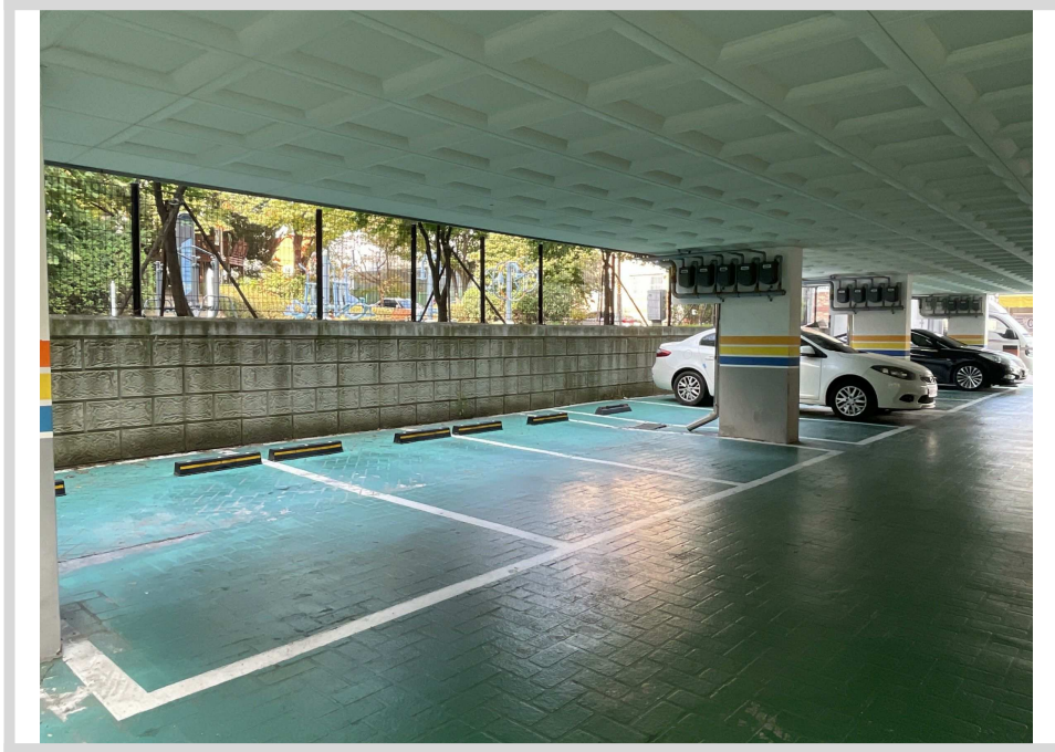
1층 공용 주차장 전경
