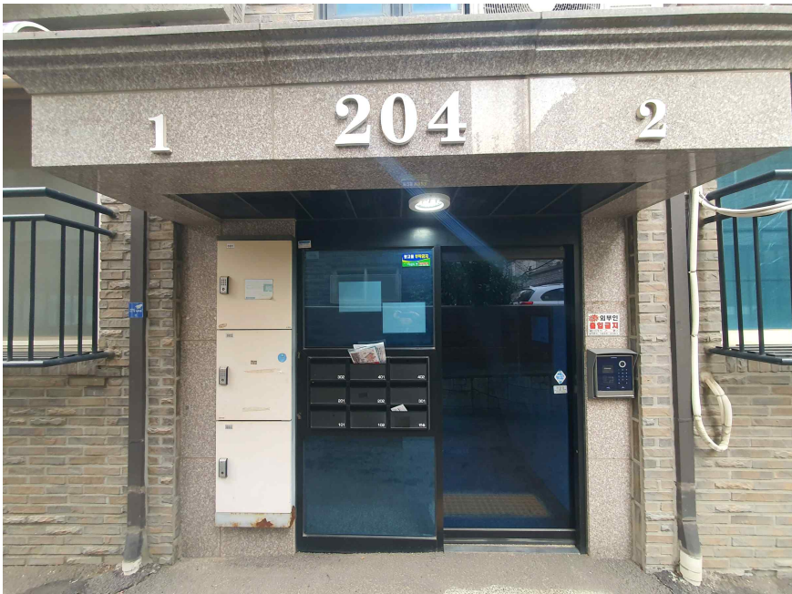
본건 1층 공동현관
