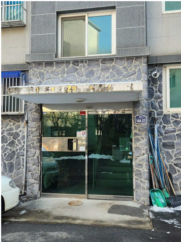
본건 공동 출입구
