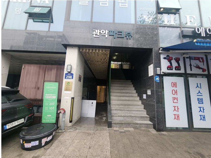
본건 1층 출입구
