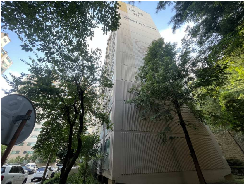
본건 건물 전경-2
