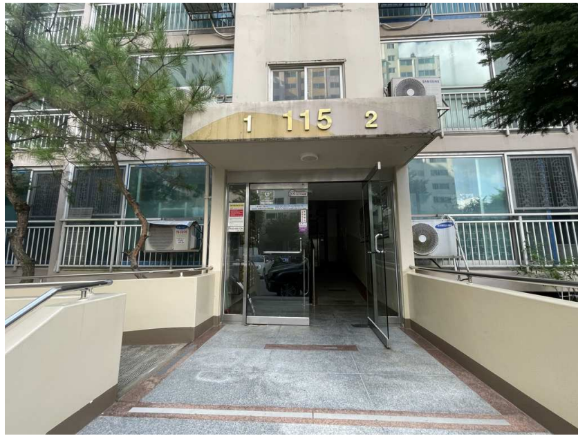
1층 공용 출입구 전경
