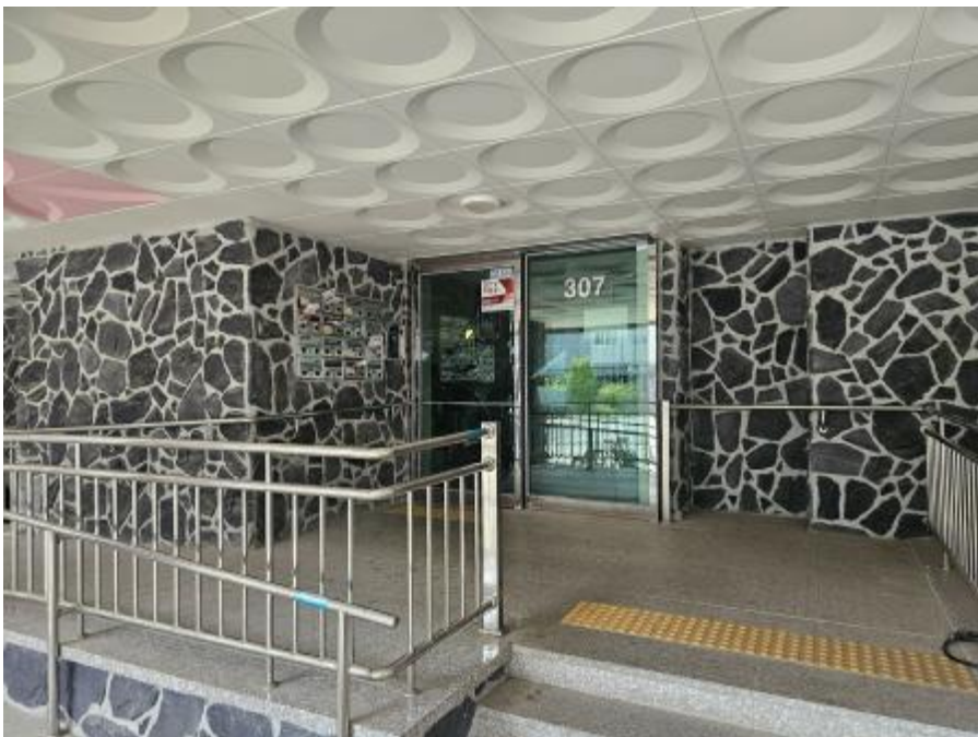
대상물건 건물 1층 출입구
