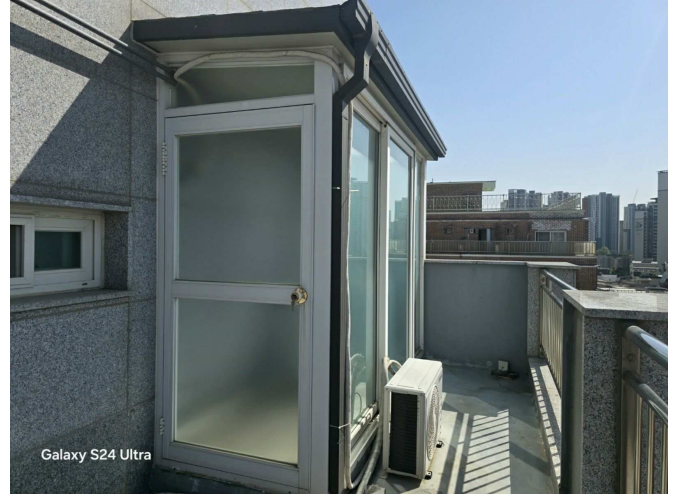
제시외 건물 ㉢ 보일러실
