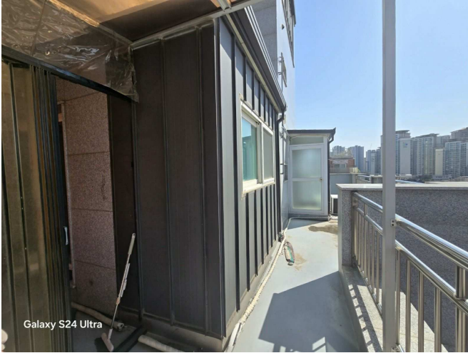
제시외 건물 ㉠ 거실 일부( 확장 베란다)와 ㉡ 보일러실
