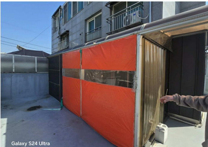
제시외 건물 ㉣ 캐노피 및 다용도실
