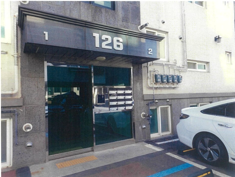
126동 공동출입문 전경
