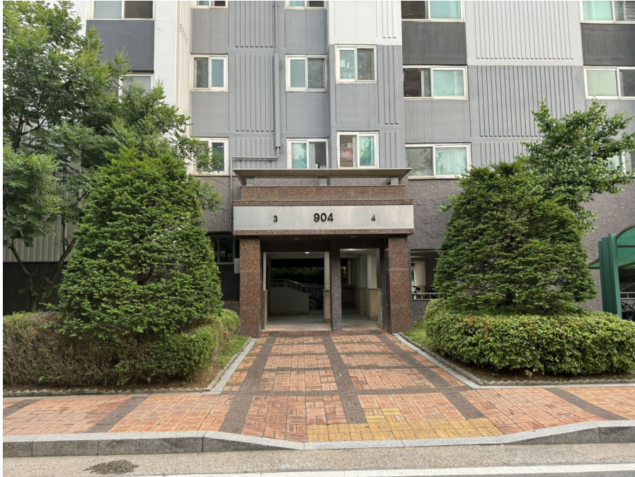
904동 1층 출입문
