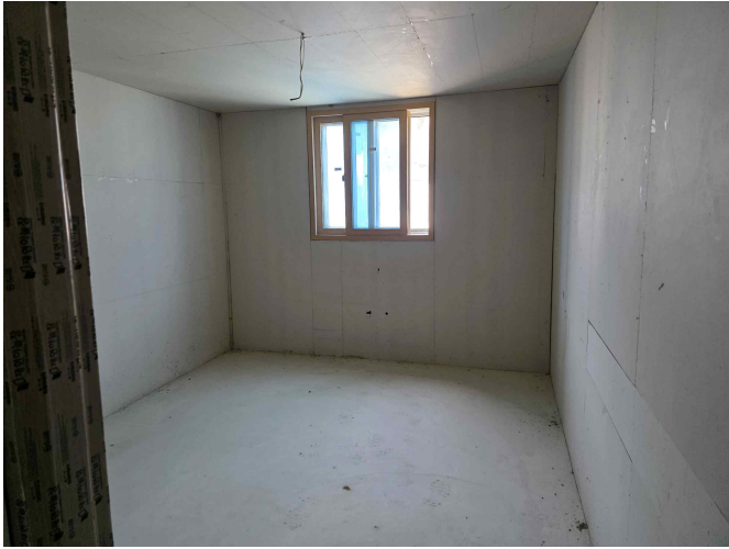
일련번호(1) 건물 2층 내부 전경
