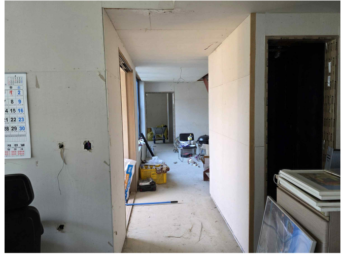
일련번호(1) 건물 1층 내부 전경
