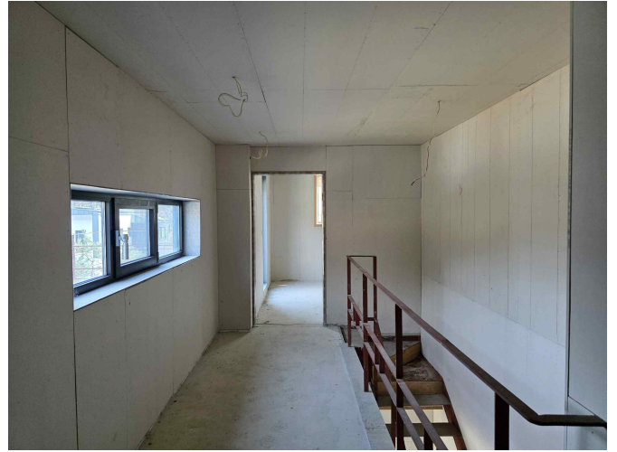
일련번호(1) 건물 2층 내부 전경
