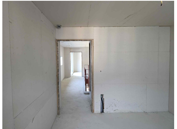
일련번호(1) 건물 2층 내부 전경
