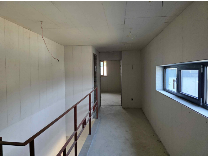
일련번호(1) 건물 2층 내부 전경
