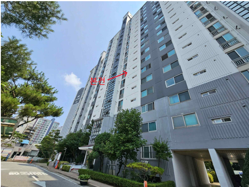
본건 전경 (남서측 촬영)
