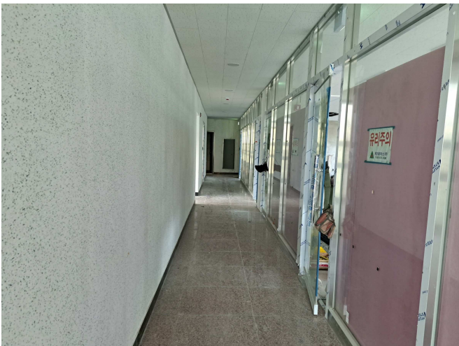
2층 복도 전경
