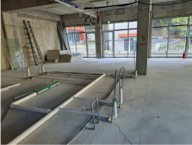
1층 101호, 102호, 103호 실내 전경
