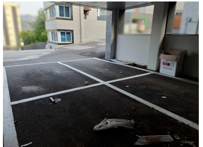
지하1층 실내 주차장 전경
