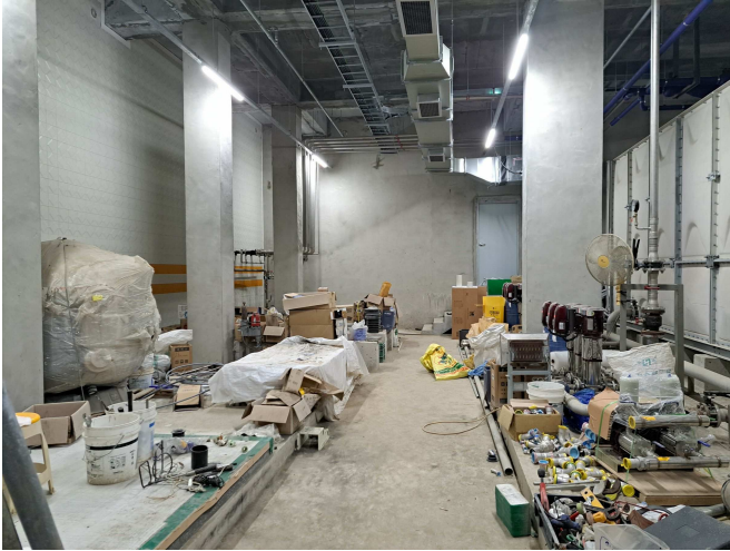
지하1층 실내 전경
