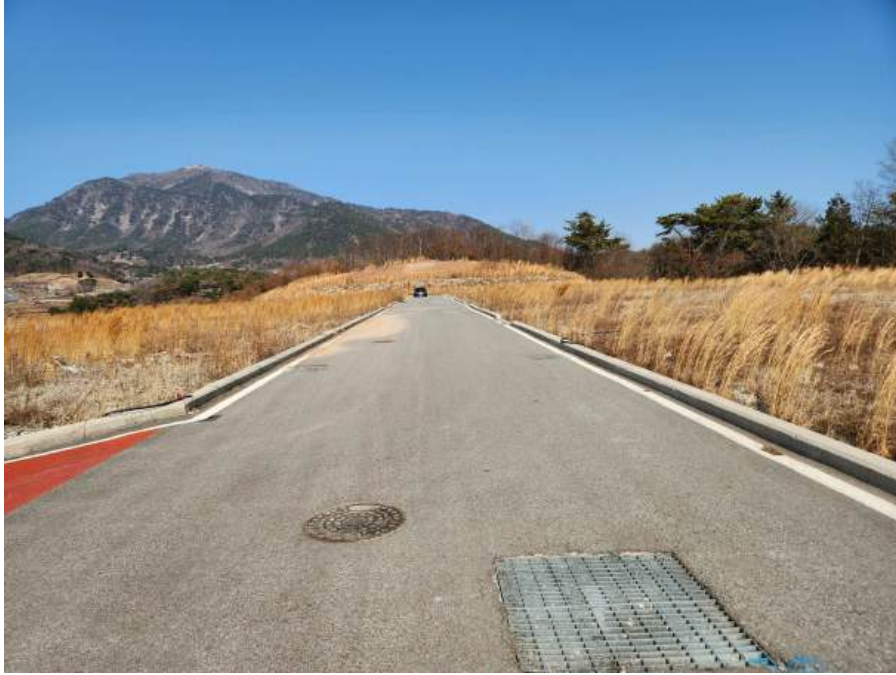
기호5 내부 포장도로 상태 등 도로포장 등은 토지에 참작하여 평가하였음.
