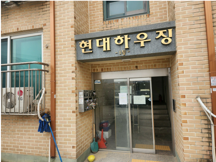
본건라인 1층 출입구
