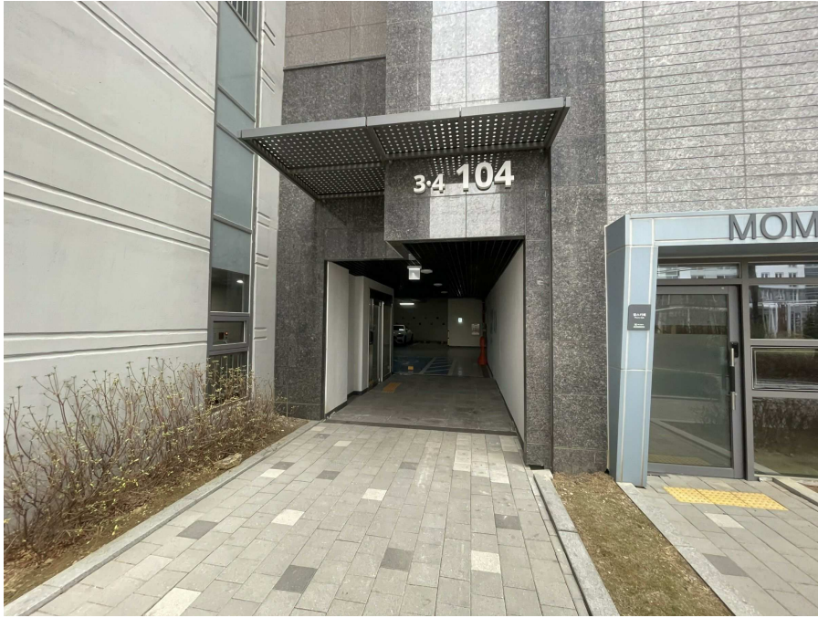
1층 공동 현관문
