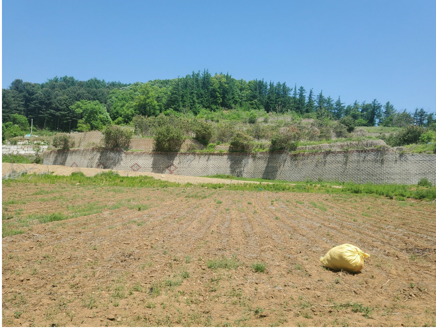
본건 전경(남측 촬영)
