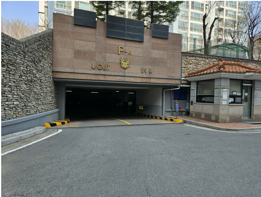
지하 주차장 출입구
