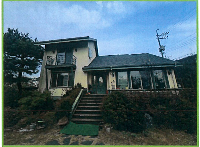
본 건물 전경
