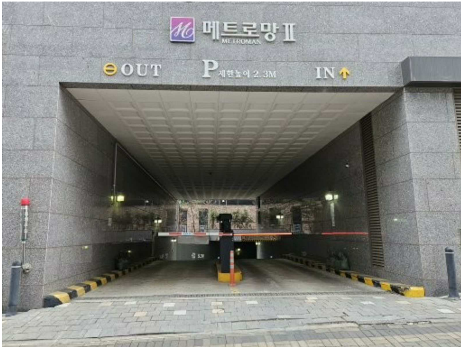
지하 주차장 출입구
