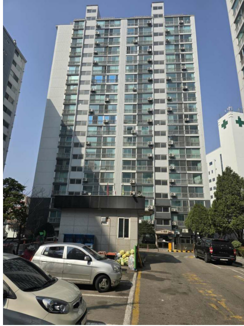
대명아파트 제108동 전경
