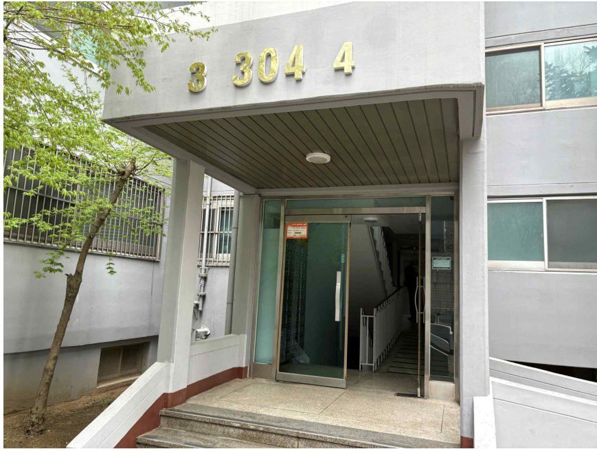
대상물건이 속한 건물 주출입로
