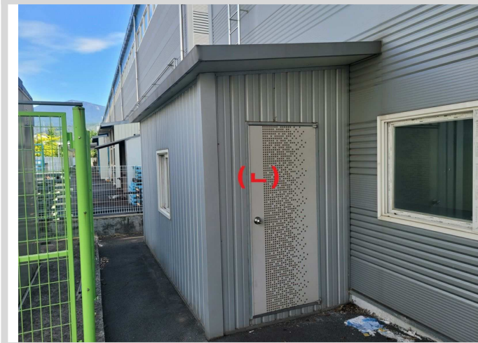
제시외건물(ㄴ) 전경 (서측에서 촬영)
