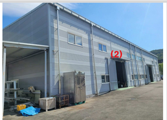
기호(2) 건물 공장부분 전경 (북서측에서 촬영)
