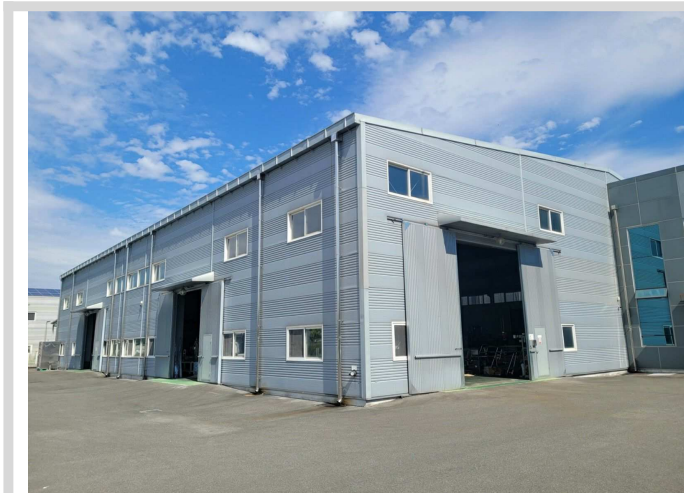
기호(2) 건물 공장부분 전경 (남측에서 촬영)
