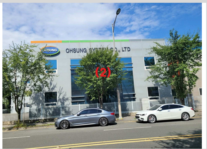
기호(2) 건물 사무실부분 전경 (남동측에서 촬영)
