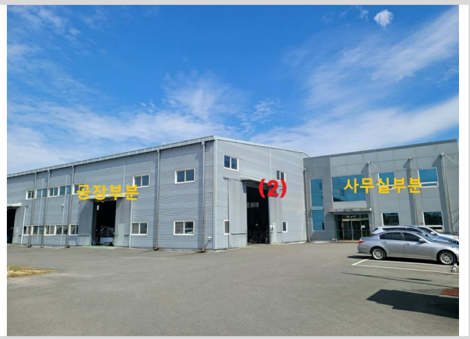
기호(2) 건물 전경 (남측 주변에서 촬영)
