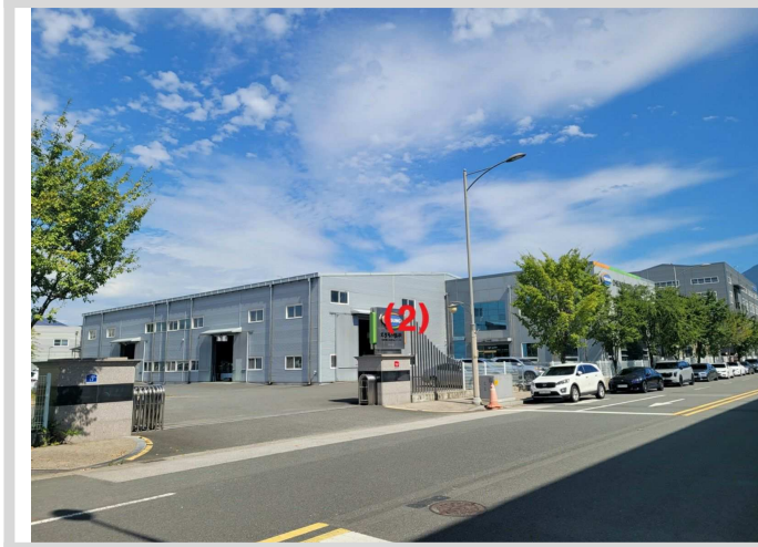
기호(2) 건물 및 주변전경
