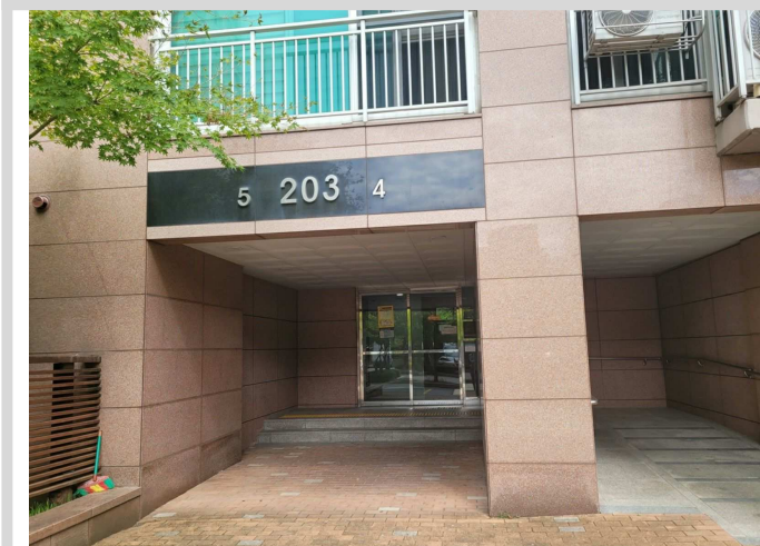
건물동 호별라인 공동출입구 전경
