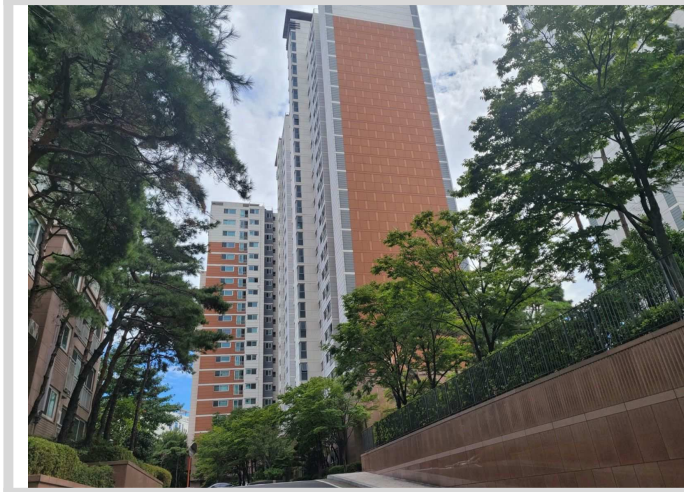
본건(505호) 소재 건물동 전경 (북서측 주변에서 촬영)
