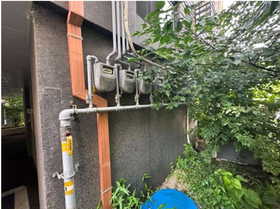
본건건물(202동) 외부 전경
