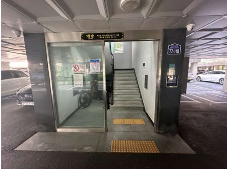
본건건물(202동) 1층 출입구 전경
