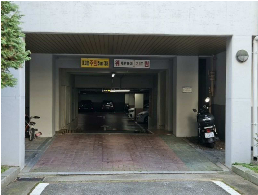
지하 주차장 출입구
