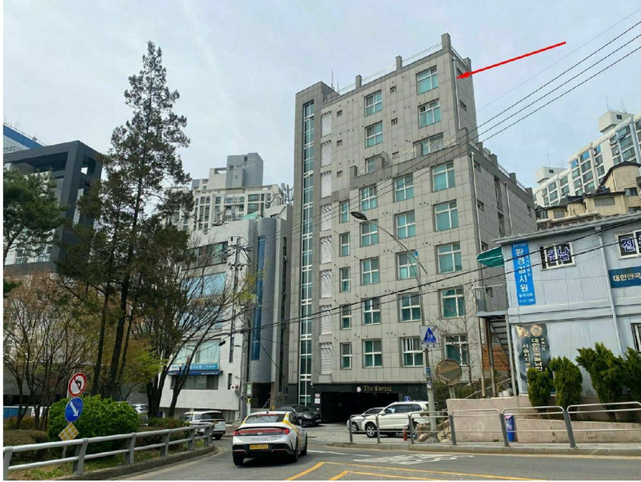
본건이 소재한 건물 전경
